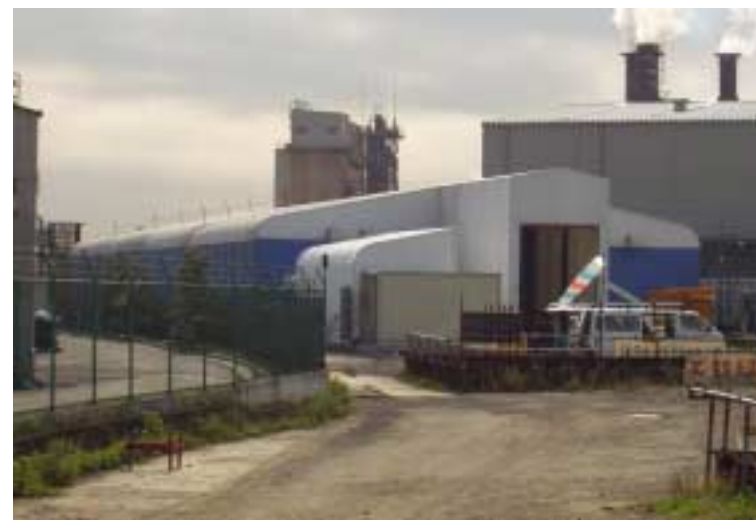
テント設置状況
