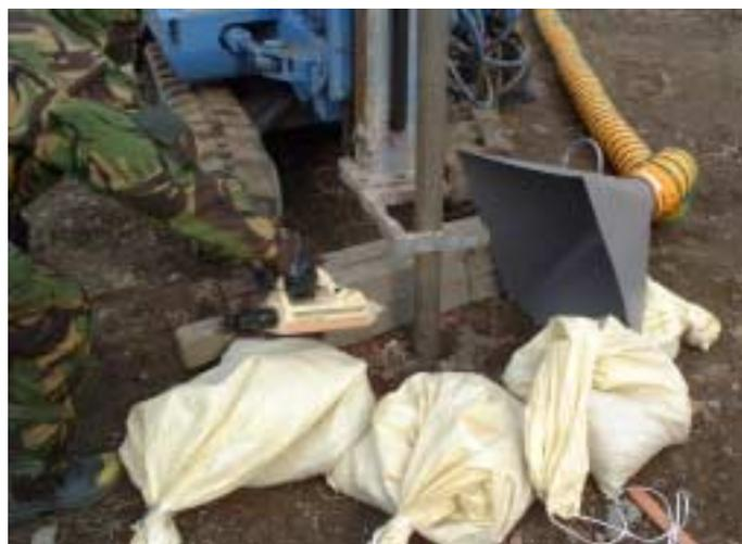
ボーリング作業時のガス検知調査(常時)
