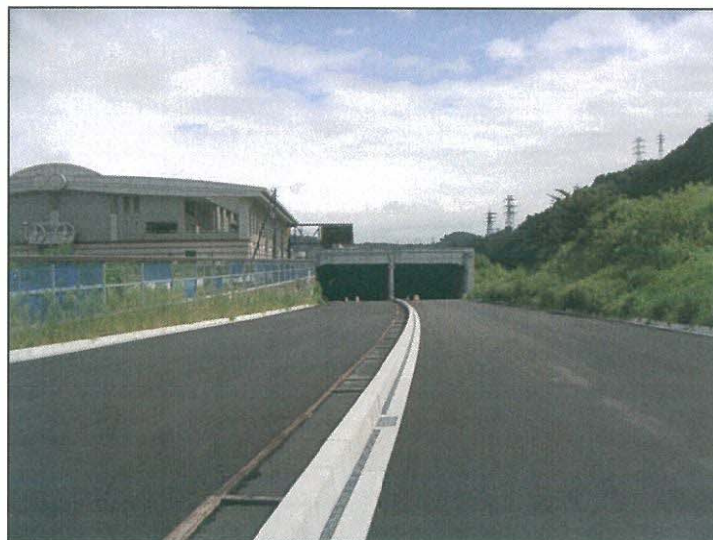
図 本線部の工事進捗状況(H16.9撮影)
