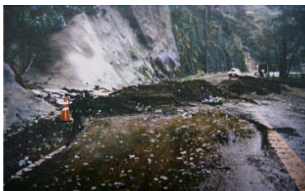
通行規制区間における土砂崩落状況 (H10.8.30)
