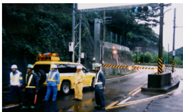
供用前の通行規制状況
