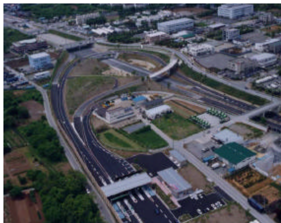
日の出インターチェンジ(東京都日の出町)
