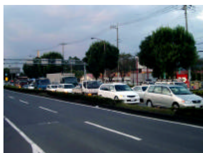
国道 408 号 (学園都市南入口交差点) の混雑 (成田方向)
