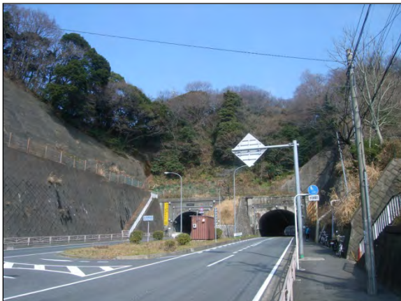
吹付法枠施工前
