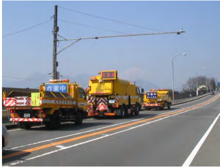
清 掃 (路面清掃・排水施設清掃等)
