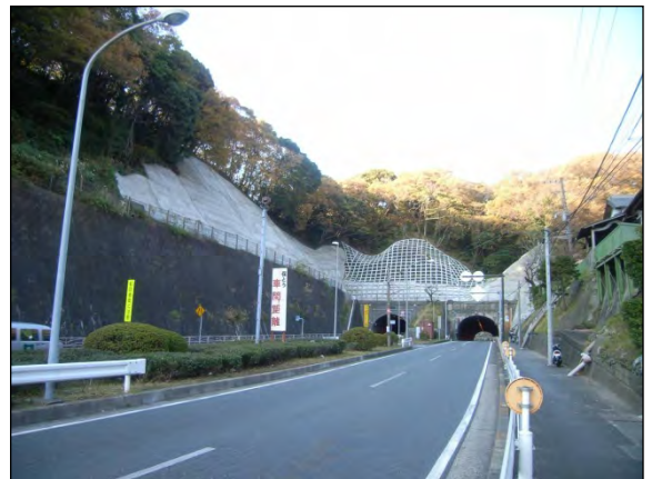
吹付法枠施工後
