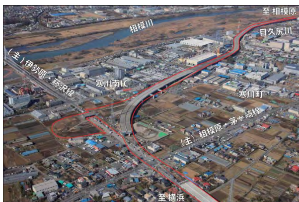
寒川南IC付近(平成24年1月撮影)
