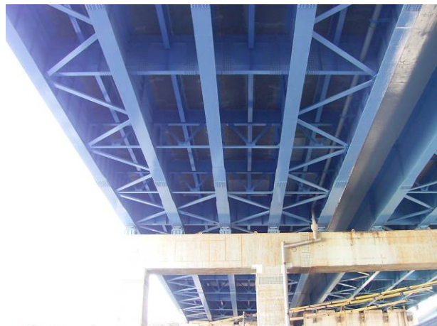
補修工事が終了した国道16号南本宿高架橋 (縦桁を増設することで床版を補強した。)
