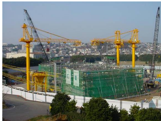
トンネル立坑 (横浜湘南道路)
