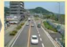
国道1号風祭交差点 (部分開通後)
