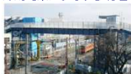
歩行者横断立体施設の設置
