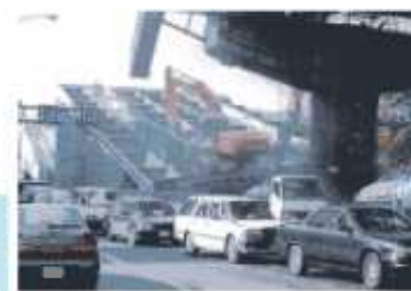
阪神淡路大震災による被災の様子
