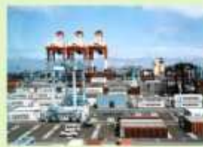
横浜港 コンテナハース
