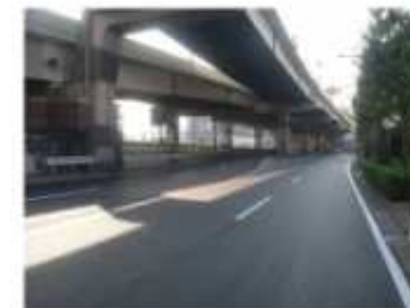
高性能舗装の整備例（一般国道1号）
