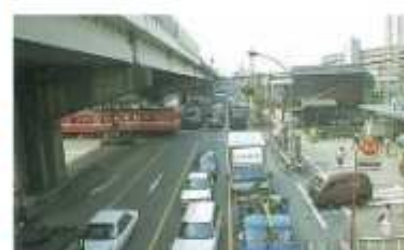
産業道路第1踏切道(現況)
