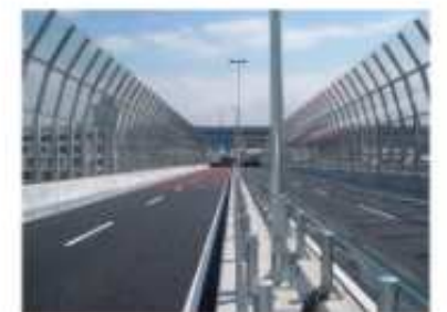
遮音壁の整備例（環状2号線）
