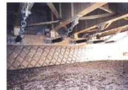
落橋防止装置の設置の例
