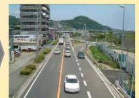
国道1号風祭交差点(部分開通後)
