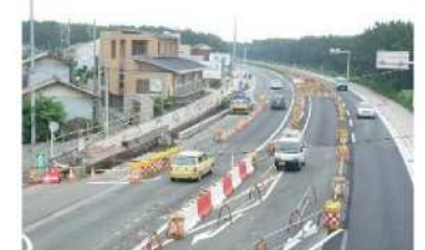
国道134号 茅ヶ崎拡幅(整備状況)
