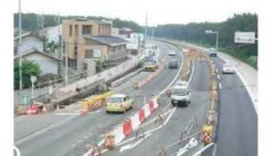
国道134号 茅ヶ崎拡幅(整備状況)
