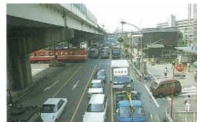
産業道路第1踏切道(現況)
