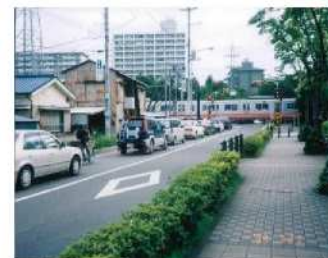
天王町2号踏切(現況)
