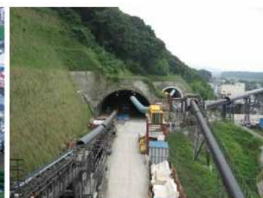
愛川トンネル（仮称）坑口
