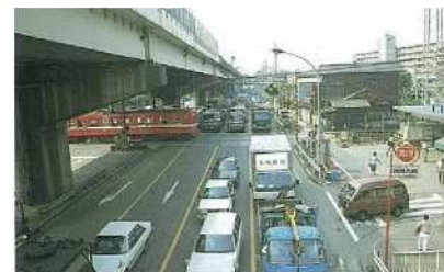
産業道路第1踏切道(現況)
