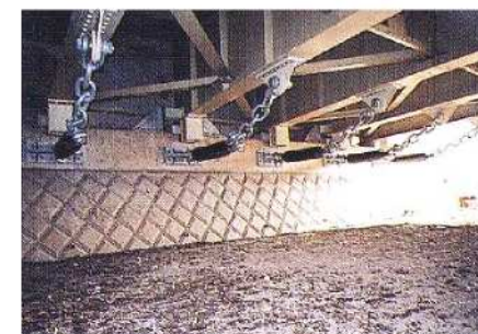
落橋防止装置の設置の例 出典：神奈川県資料
