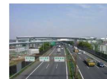
東名高速道路に連結するさがみ縦貫道路（海老名北JCT（仮称）付近）
