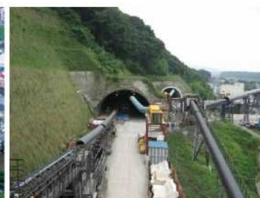
愛川トンネル（仮称）坑口
