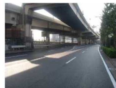
高性能舗装の整備例（一般国道1号）
