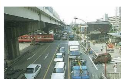
産業道路第1踏切道(現況)
