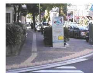
交差点隅切り部の段差の解消 (川崎市宮前区宮前平) 出典：川崎市資料
