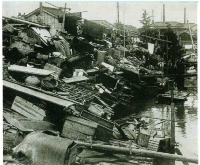
亀戸町屋上生活の惨状
