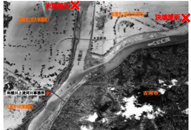
昭和22年9月22日の様子(破堤6日後)
