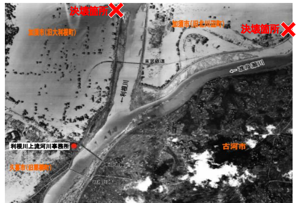
昭和22年9月22日の様子(破堤6日後) (出典:利根川・江戸川河川整備計画)
