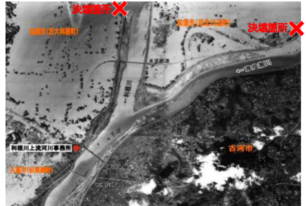
昭和22年9月22日の様子(破堤6日後)
