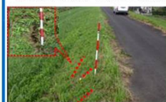
①対応後(法面補修)
