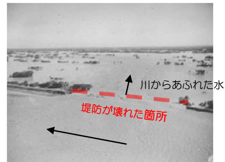
破堤箇所（現加須市）
