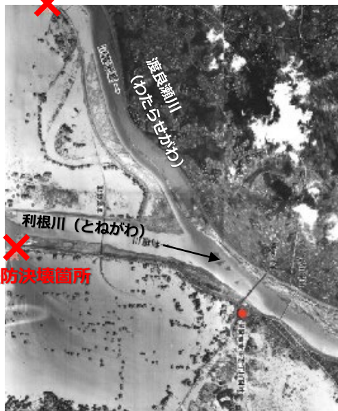
堤防決壊箇所
