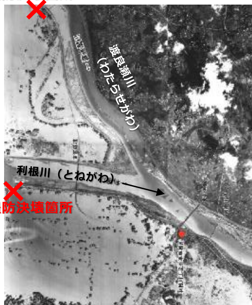
堤防決壊箇所
