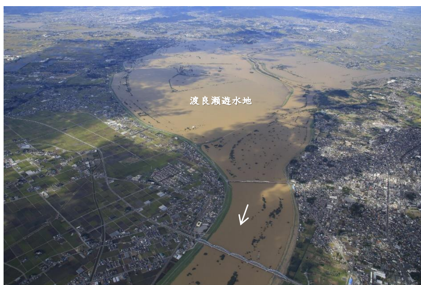
令和元年東日本台風(台風19号)による出水時の渡良瀬遊水地付近の状況
