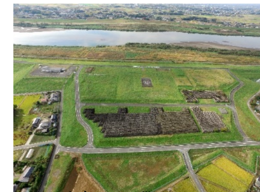
大高島河川防災ステーション
