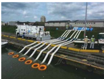
排水ポンプ車による排水状況
