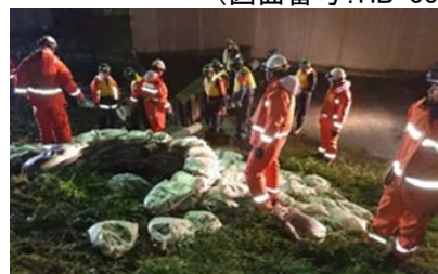
土のうの設置
