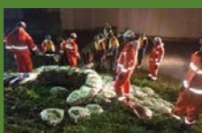
土のうの設置
