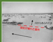
利根川の堤防決壊箇所
