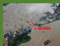
鬼怒川の堤防決壊箇所
