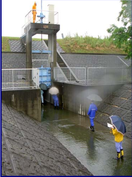
【水路内より水門ゲート開閉を確認】
