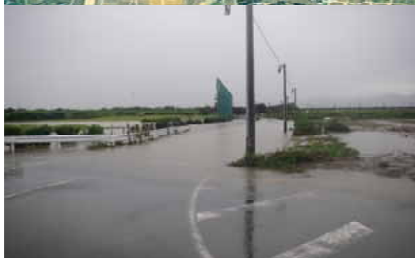
無堤箇所浸水状況
