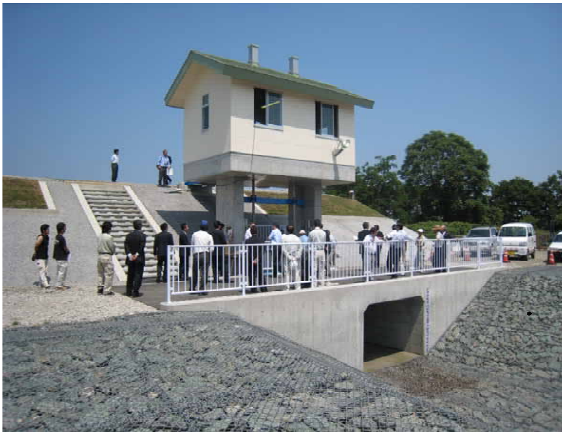
( 樋管試運転を見守る参加者 )
