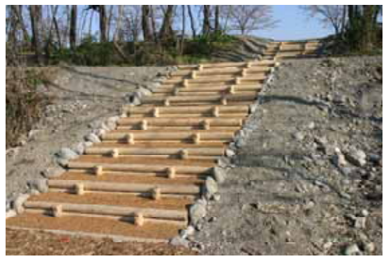
間伐材を用いた丸太階段
