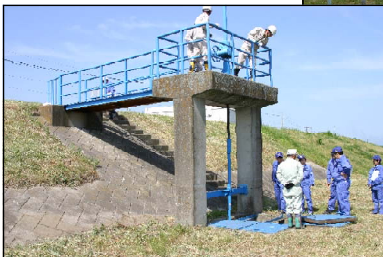
検査風景（新町樋管）
