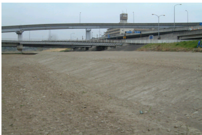
(高松環境護岸工事)
