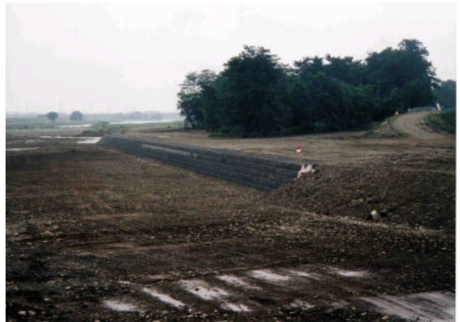
（森新田護岸災害復旧工事）
