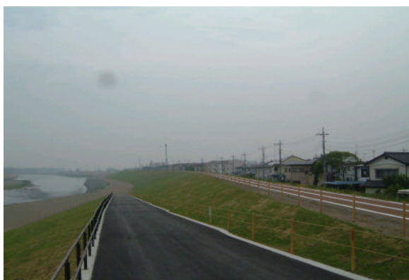
(新町地区堤防補強工事完成写真)
