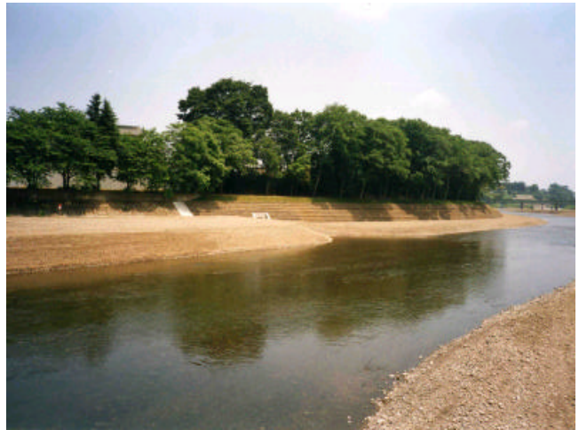
(和田多中護岸工事)
