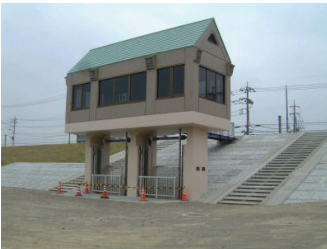
（新立石樋管新設工事）
