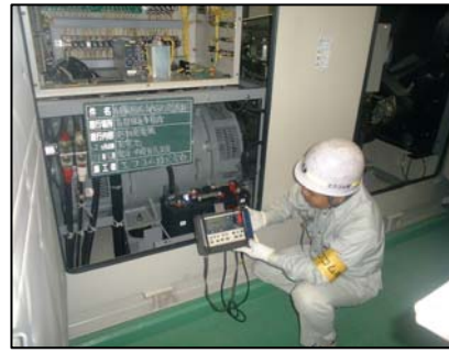
〈発電設備（蓄電池等点検）〉
