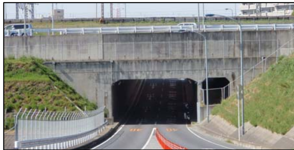
〈国道298号 上矢切隧道 (国道6号交差部)〉
