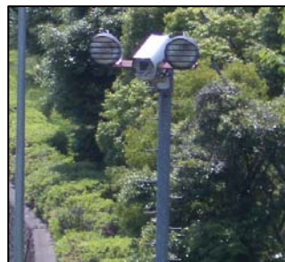
〈国道298号 上矢切隧道CCTV〉
