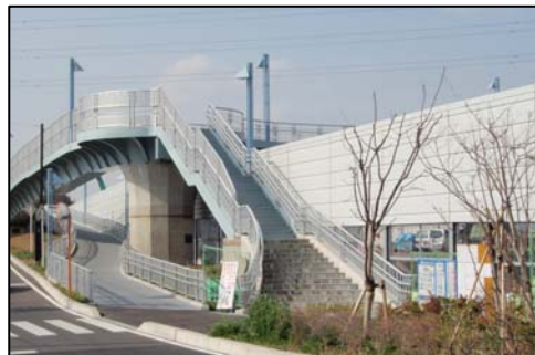
〈国道298号 矢切南台歩道橋 (横断歩道橋)〉
