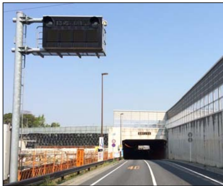
〈国道298号 上矢切付近〉
