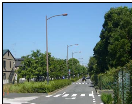
〈国道298号 上矢切付近〉
