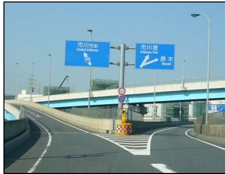
〈国道298号 高谷ランプ付近〉
