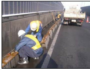
〈側溝清掃（機械）〉
