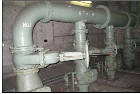
〈国道298号 小山排水機場〉
