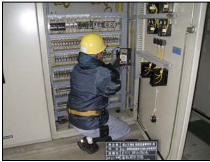
〈排水設備（電源装置点検）〉
