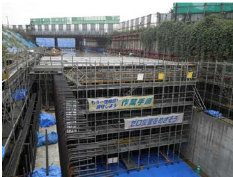
【施工中の写真】
