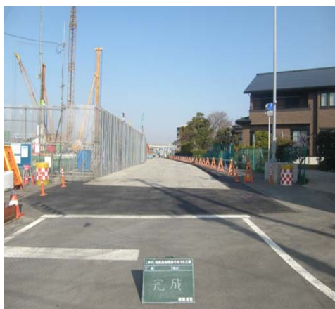
【地上部完成写真】
