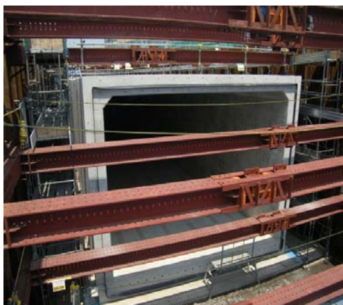
【施工中の写真】
