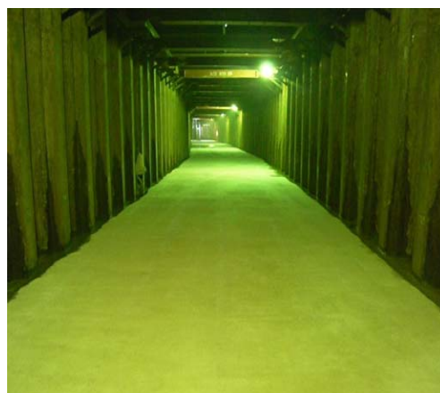
【水路部完成写真】
