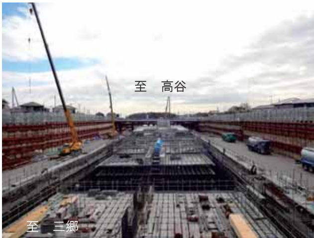
A まつど やきり ちく かんきょこうじ 松戸市矢切地区函渠工事状況
