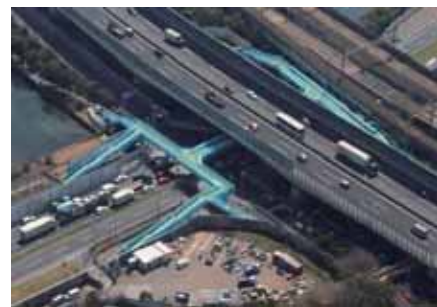
新設歩道橋（平成25年4月5日完成）
