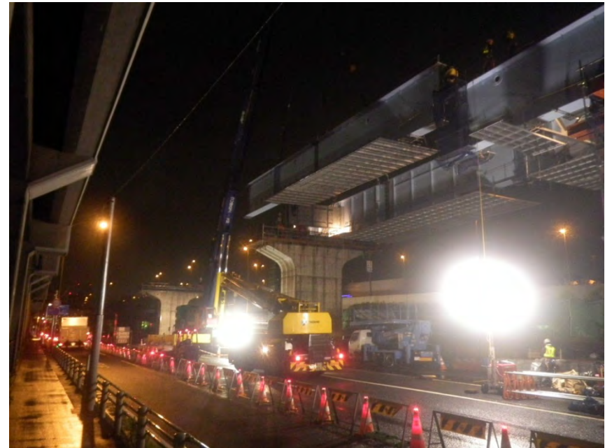
大型クレーンによる下面足場併設による桁架設
