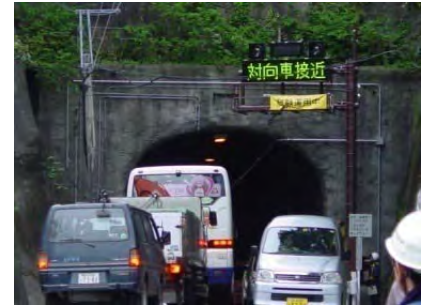
道幅の狭い坂下トンネル
