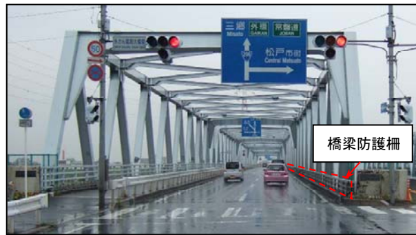
国道298号葛飾大橋(内廻り) (全景)
