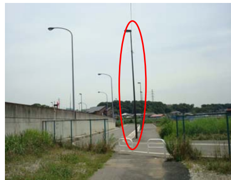
矢切インター(オフランプ側道部)
