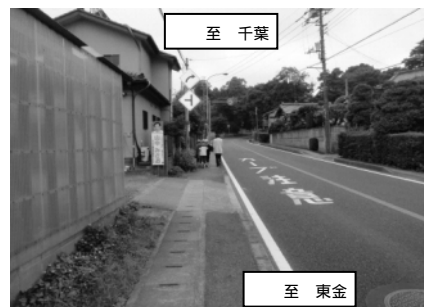
国道126号和泉町歩道設置
