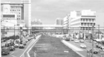
湾岸千葉地区改良(現況)
