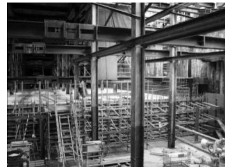
工事状況(地下立体部)
