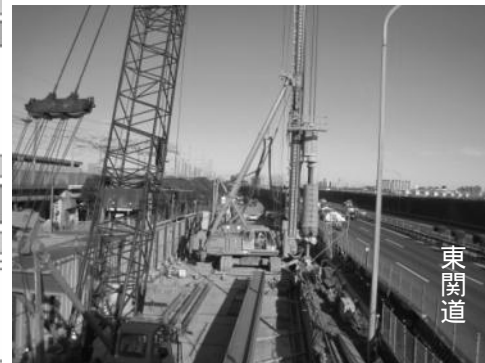
谷津船橋ICの工事状況
