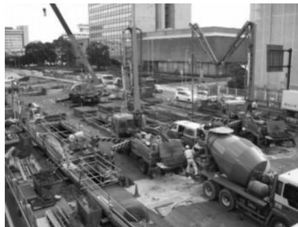
工事状況(地上部)
