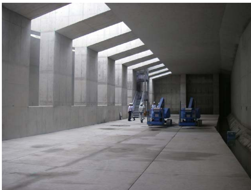
国分地区掘割部試験工事
