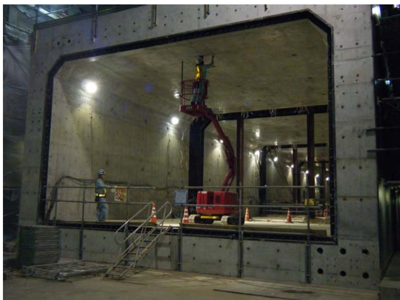
小塚山トンネル工事
