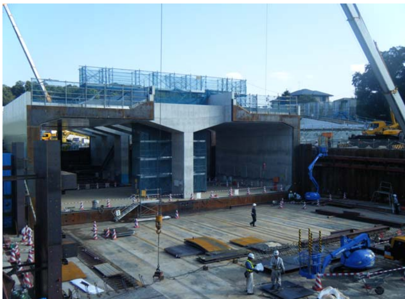
北総線交差部工事
