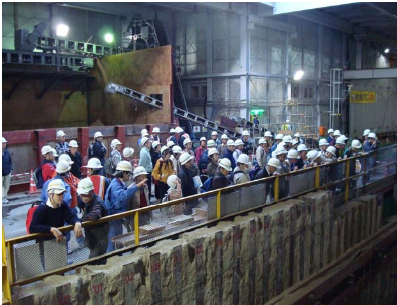
小塚山トンネル工事
