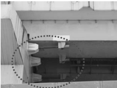
—縁端拡幅ブラケットによる桁の落下防止—
