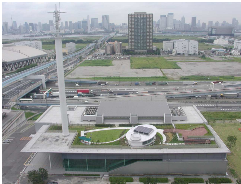
防災拠点施設（本部棟）
