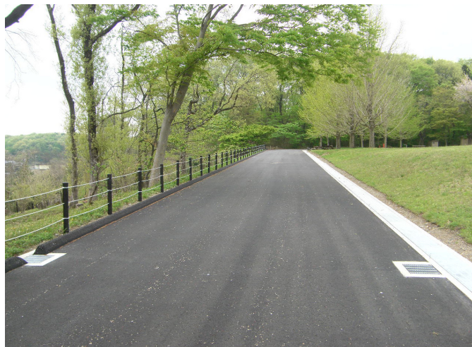
舗装工、側溝工
