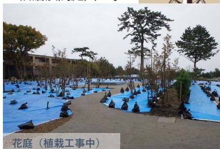
花庭(植栽工事中)
