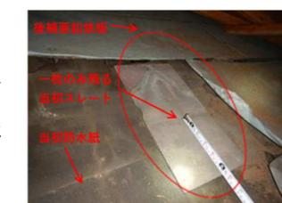
写真36 北側屋根に残るスレート材（2019年撮影）
