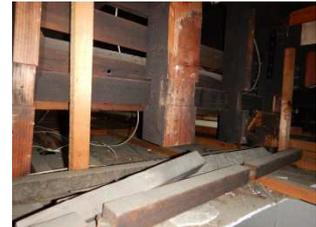
写真32 間仕切り改造による柱切断（2019年撮影）
