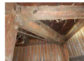
写真20 緊結鉄筋棒（2019年撮影）
