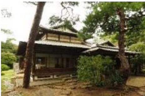
写真 35 陸奥別邸跡外観
