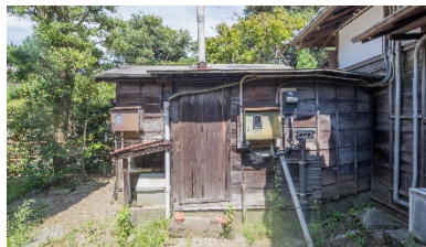
写真1 繋ぎ廊下 (R1年12月撮影)
