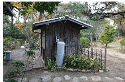
写真1 附属屋 (R1年12月撮影)
