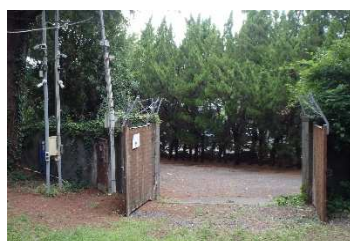
写真 22①門扉・ポンプ室（2018年撮影）
