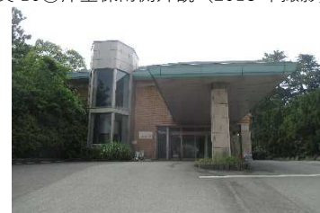
写真 11③(旧)バンケットホール 北側外観（2018 年撮影）
