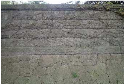
外周の石積擁壁
