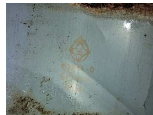
写真 37 後補屋根材 JIS (2019 年撮影)
